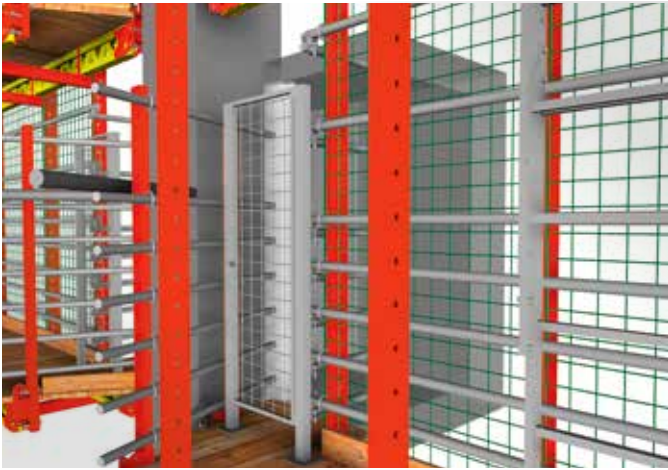
Abb. 7: Übergang vom Bauaufzug auf die Übergangsbühne
