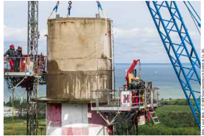
Abb. 2: Schornsteinabbruch durch Sägetechnik im Schutze von mastgeführten Kletterbühnen
